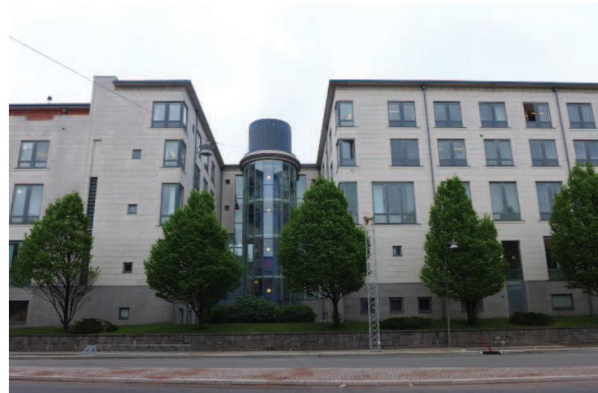
Fasad utmed Sprängkullsgatan.
